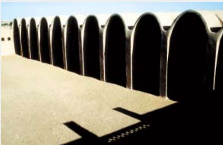
Bauen mit lokalen Baustoffen: Fathy entwickelte Kuppeln und Bogenstrukturen aus Lehm. Als Aussteifung nutzte er Palmenholz. Unten links ist der Hof des Baris-Markt abgebildet.
