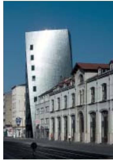
Der neugeschossige Gehry Tower in Hannover befindet sich bei einer Freifläche, genannt Am Steintor. Der skulpturale Charakter des kleinen Turms mit seinen gekrümmten Kanten verhelfen dem Ort zu einer Identität. Fotos Fotodesign Andreas Braun, DE-HamelN./Josef Gartner GmbH, DE-Gundelfingen/Donau.
